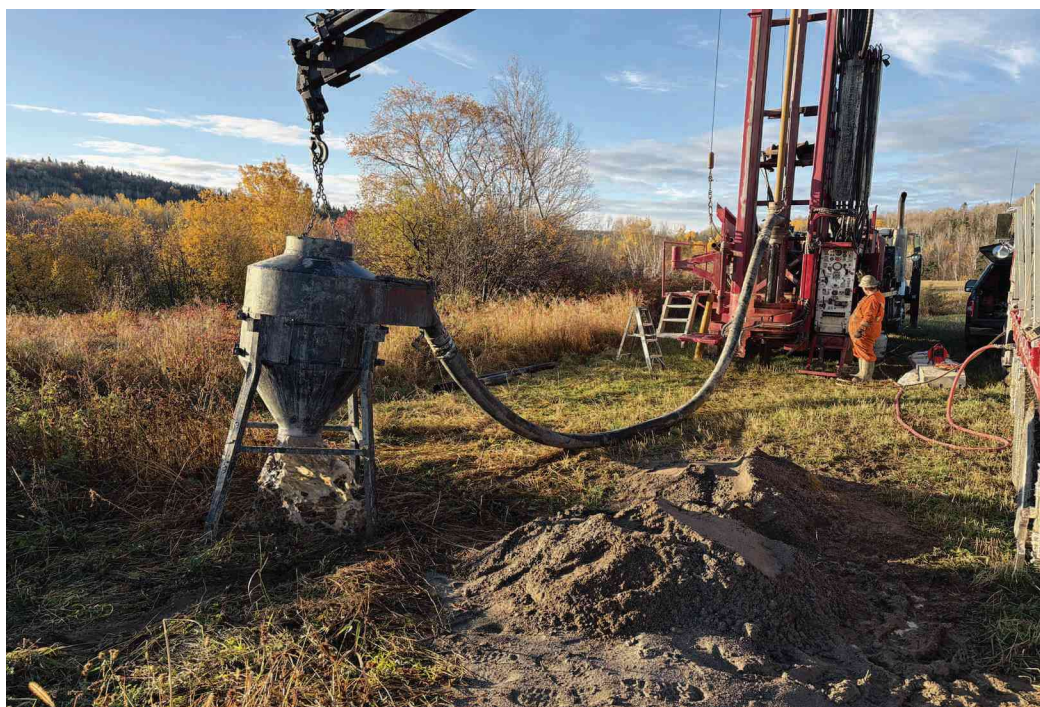
Planche 4. Vue du débit d'eau souterraine de l'ordre de 380 L/min sortant du cyclone de dépressurisation au moment de la réalisation du forage stratigraphique MB-3
