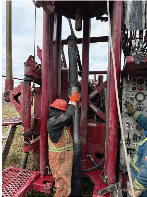
Planche 5. Vue de la manoeuvre visant à introduire l'ensemble « tube d'accouplement/crépine » à l'intérieur du tubage en acier au moment de l'aménagement des piézomètres MB-3 et MB-4
