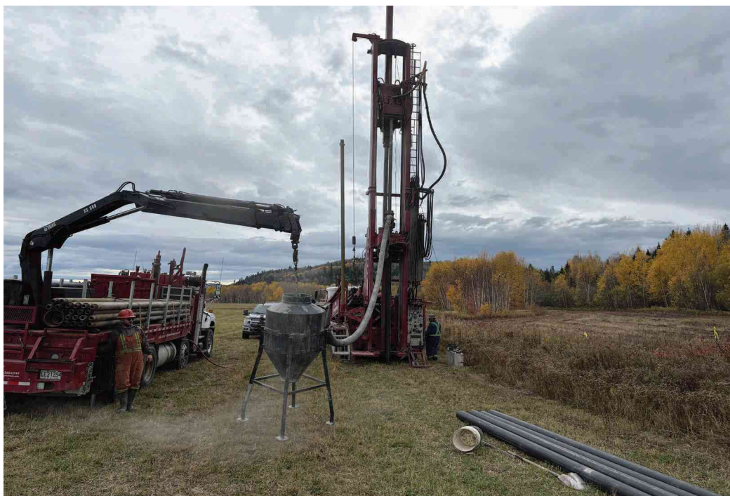
Planche 3. Vue de la foreuse « Foremost DR-24 » qui a été utilisée pour exécuter les forages stratigraphiques aménagés chacun en piézomètre de la série « MB »
